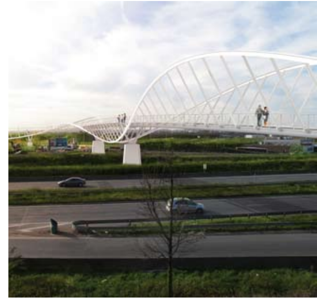
La passerelle du Tégéval
