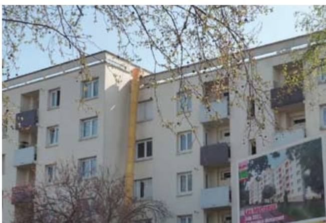
Résidence des Motteaux
