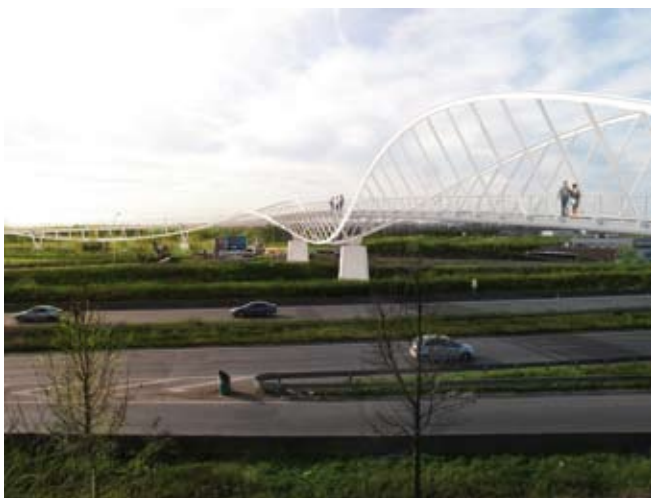
Future passerelle Tégéval
