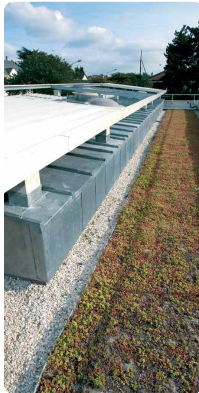
Toit des nouveaux vestiaires du stade Desmont
