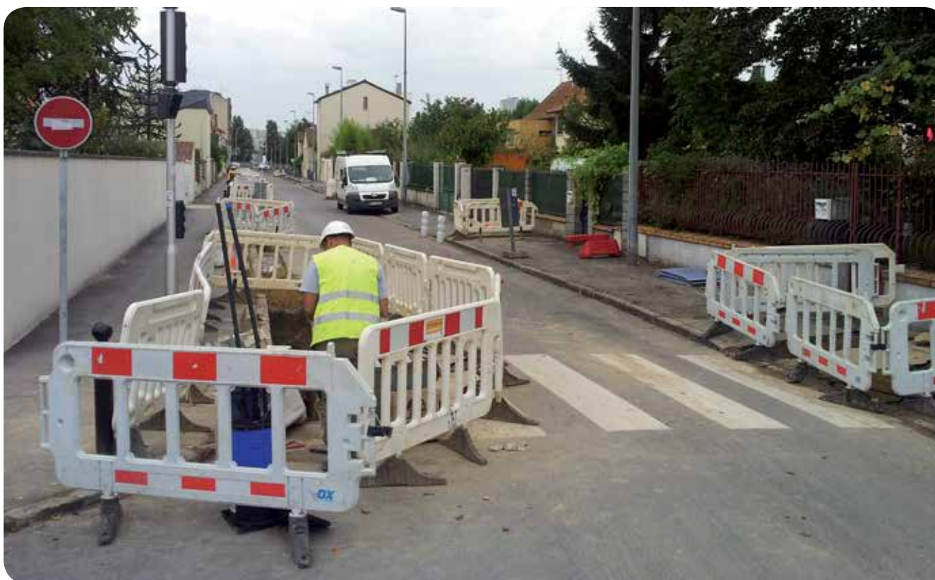
Travaux d'assainissement rue Saint Simon
