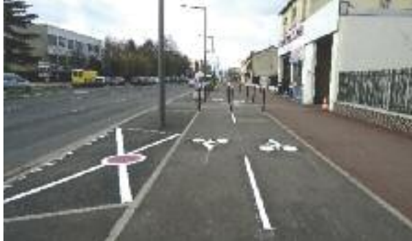
La nouvelle piste sur trottoir de la RD 19
