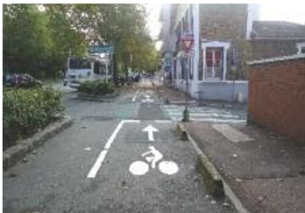
La piste cyclable rénovée de la RD 19
