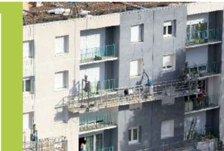
Les travaux de rénovation des logements
