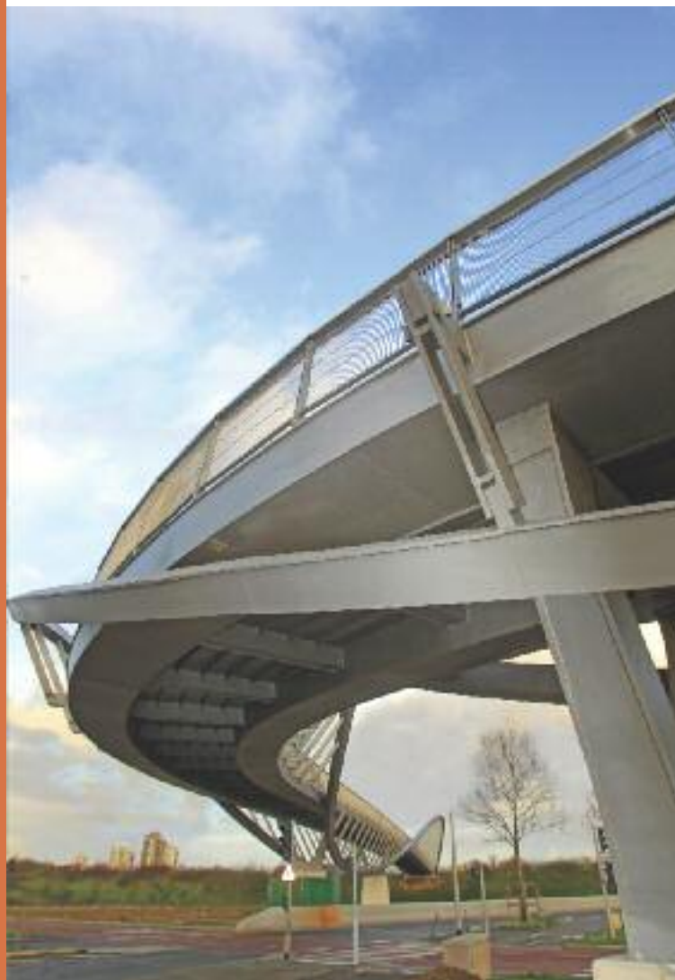
Passerelle de la Tégéval
