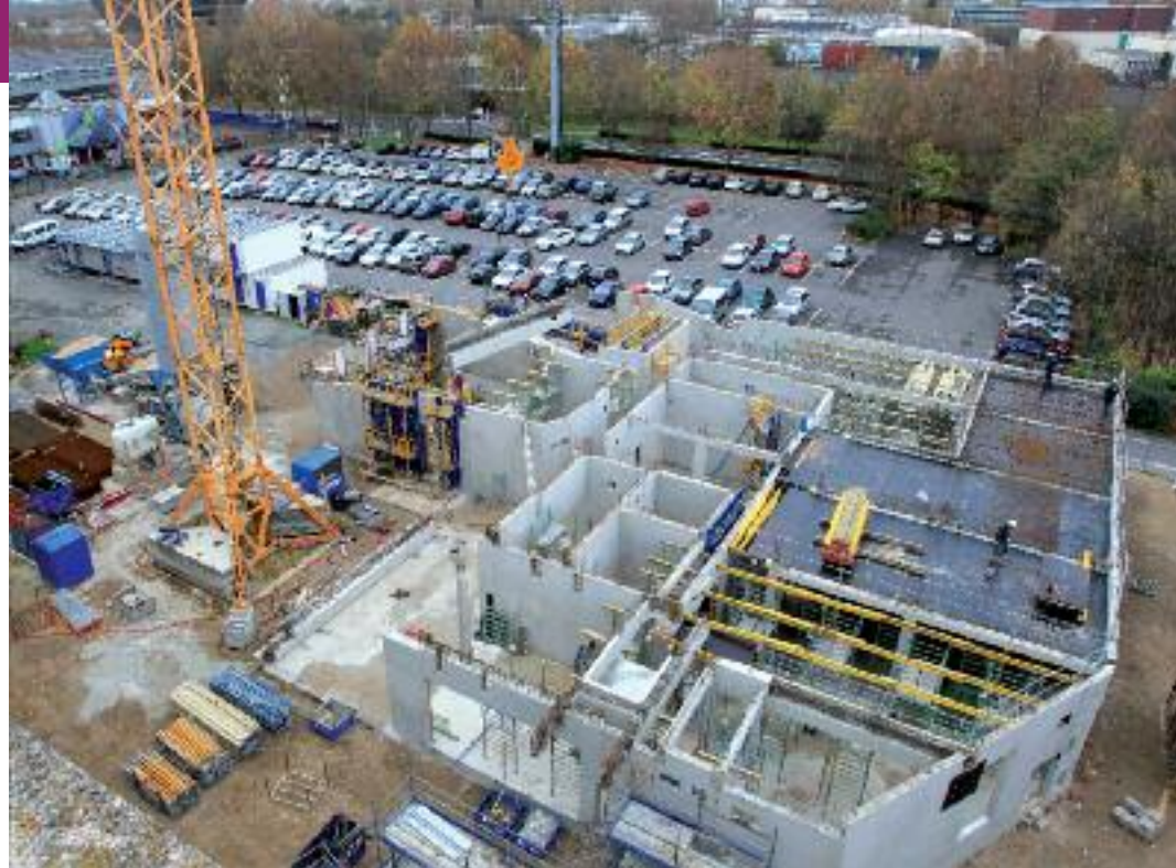
Les travaux de construction de la Maison des sciences de l'environnement
