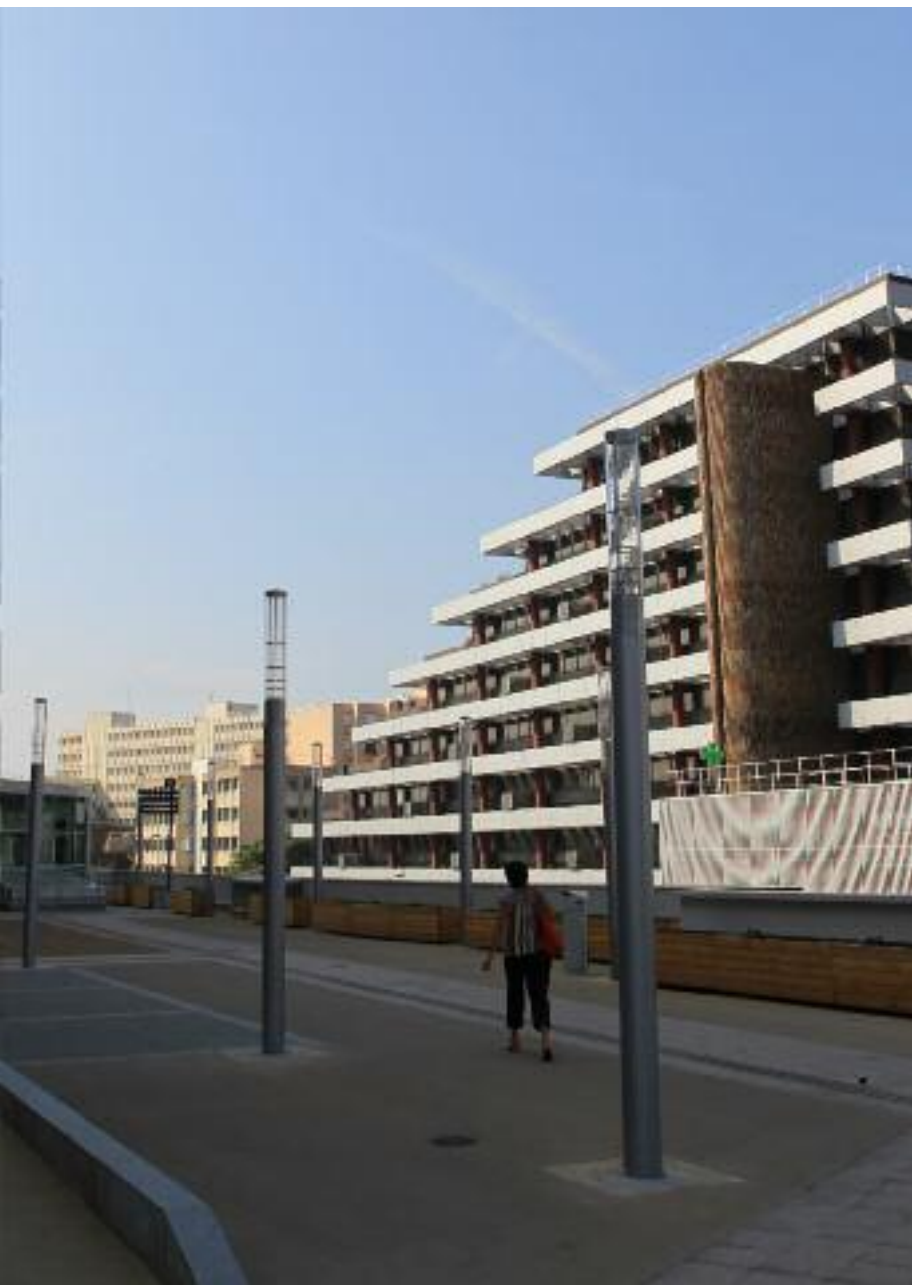
Un nouvel éclairage public plus économe et performant
