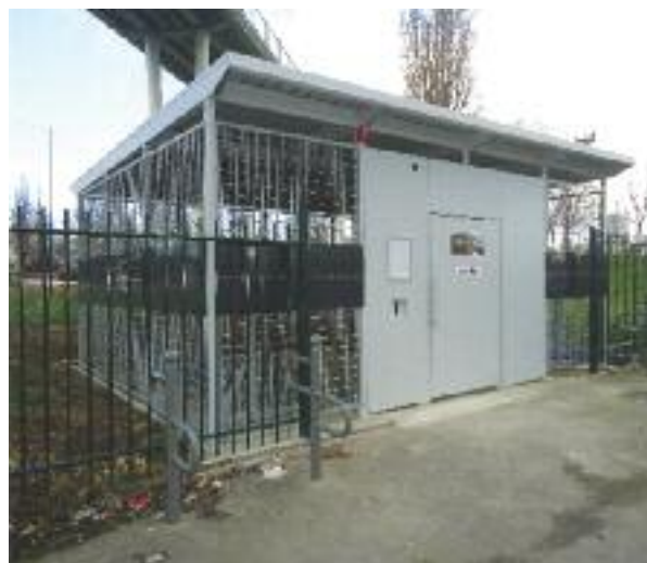
Station Véligo au pôle intermodal à Pompadour
