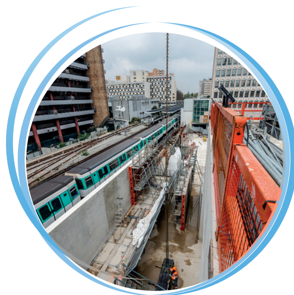
Travaux du Grand Paris Express
