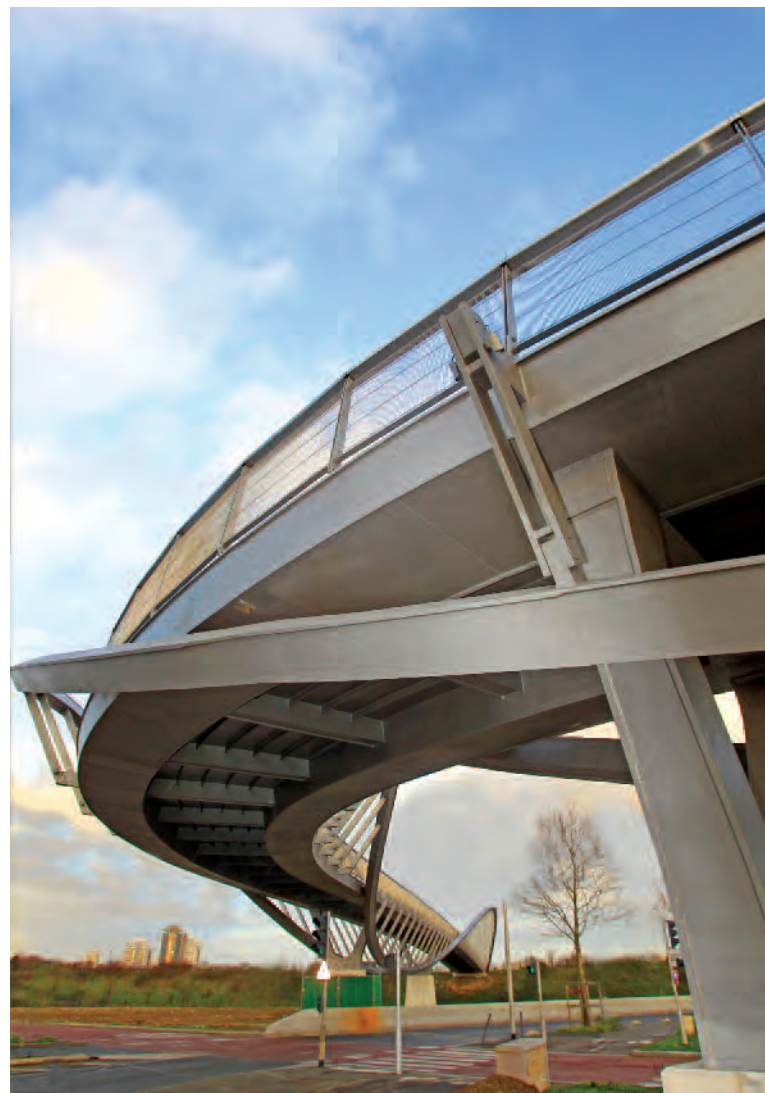
Passerelle de la Tégéval
