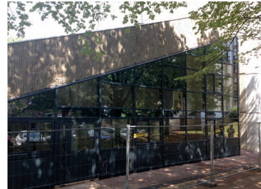
Le remplacement des deux façades du bâtiment Gounod
