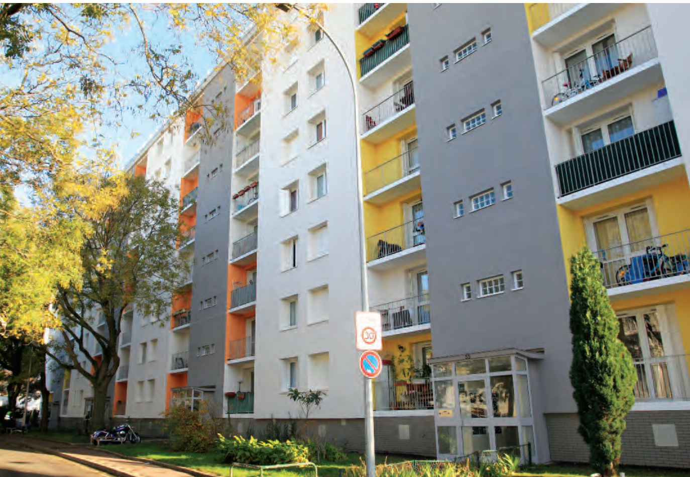
La rénovation thermique menée par Créteil Habitat
