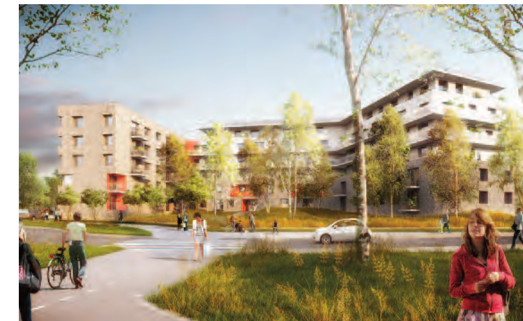
65 logements sociaux dans le quartier Déménitroux
