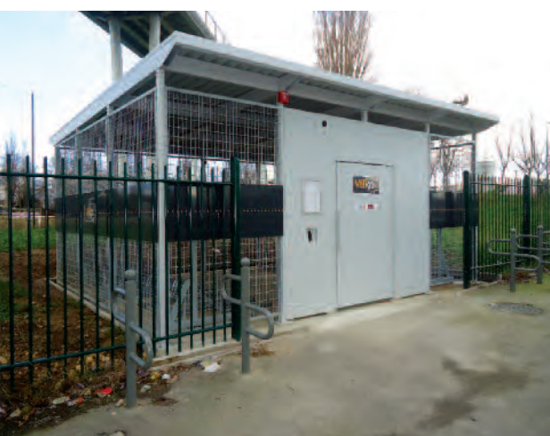
Station Véligo au pôle intermodal à Pompadour
