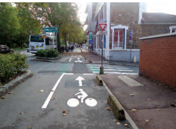
La piste cyclable rénovée de la RD 19
