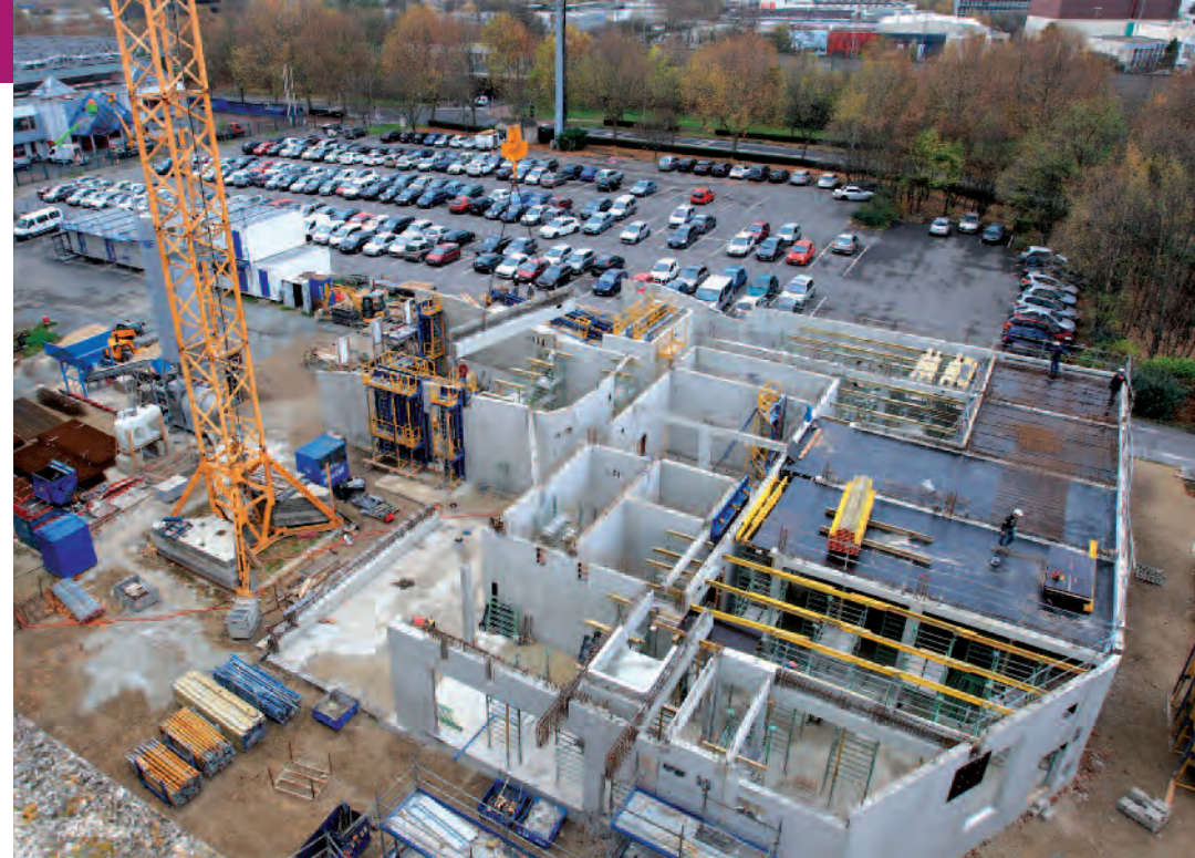
Les travaux de construction de la Maison des sciences de l'environnement
