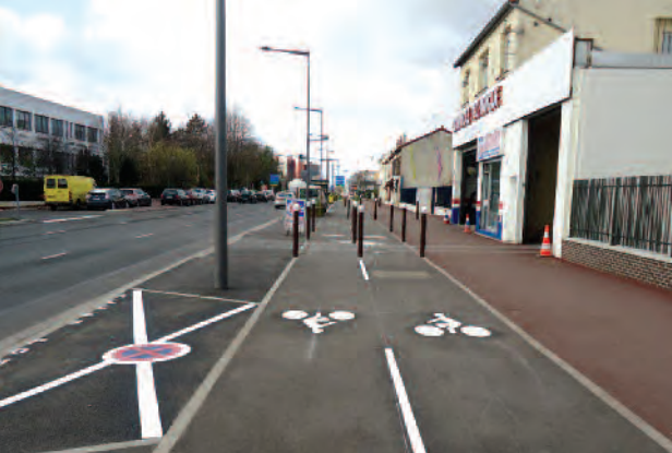
La nouvelle piste sur trottoir de la RD 19
